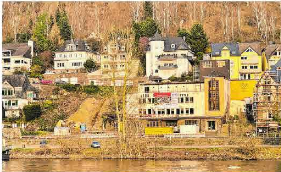
Das alte Kellereigebäude der Firma »Hieronimi« soll in Kürze abgerissen werden. Foto: Zender
